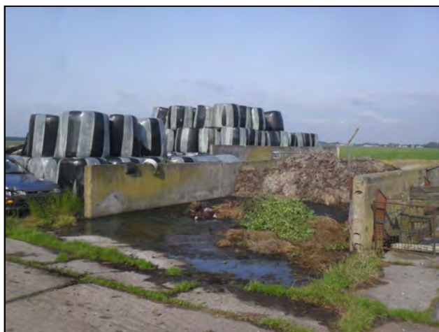
Foto 4 : te amoveren silo's
