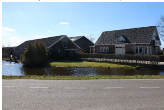
Rechts woning, midden en links te slopen schuren.
