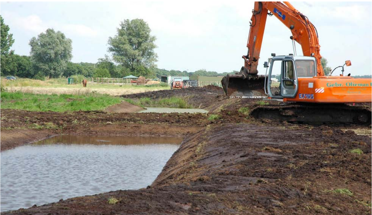
Figuur 10: Graven van een watergang
