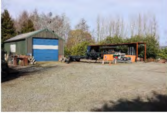
Buitenterrein met de bestaande loods.
