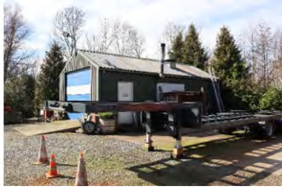
Te slopen gebouw.
