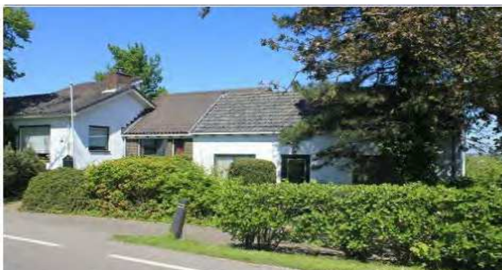
Fig. 3.6: Bestaande bebouwing Kaagjesland 62-64
