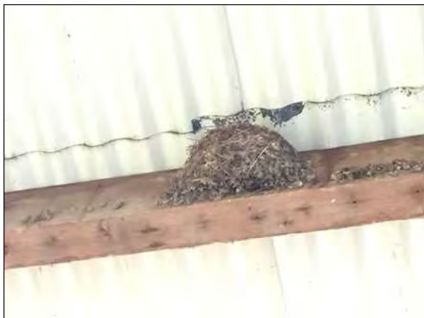
Oud nest van een boerenwaluw in één van de te slopen gebouwen in het plangebied.
