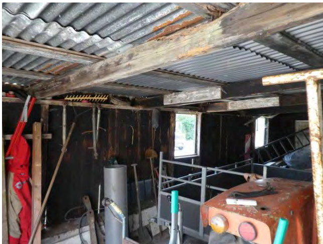
Figuur 11: Binnenkant schuur 2
