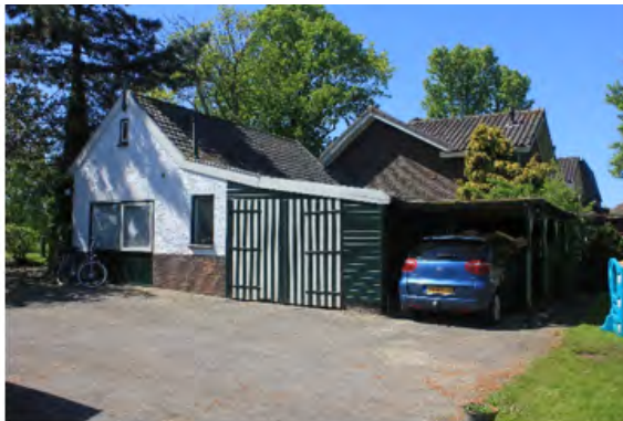
Bedrijfsruimte en garage vanaf oostzijde.
