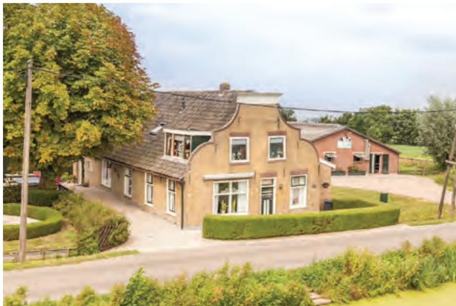
Vergelijkbare kopgevel bij Achterbroek 87 te Berkenwoude
