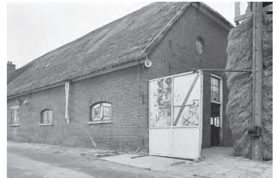
Vergelijkbaar metselwerk bij het zomerhuis van Meije 131 (rijksmonument)
