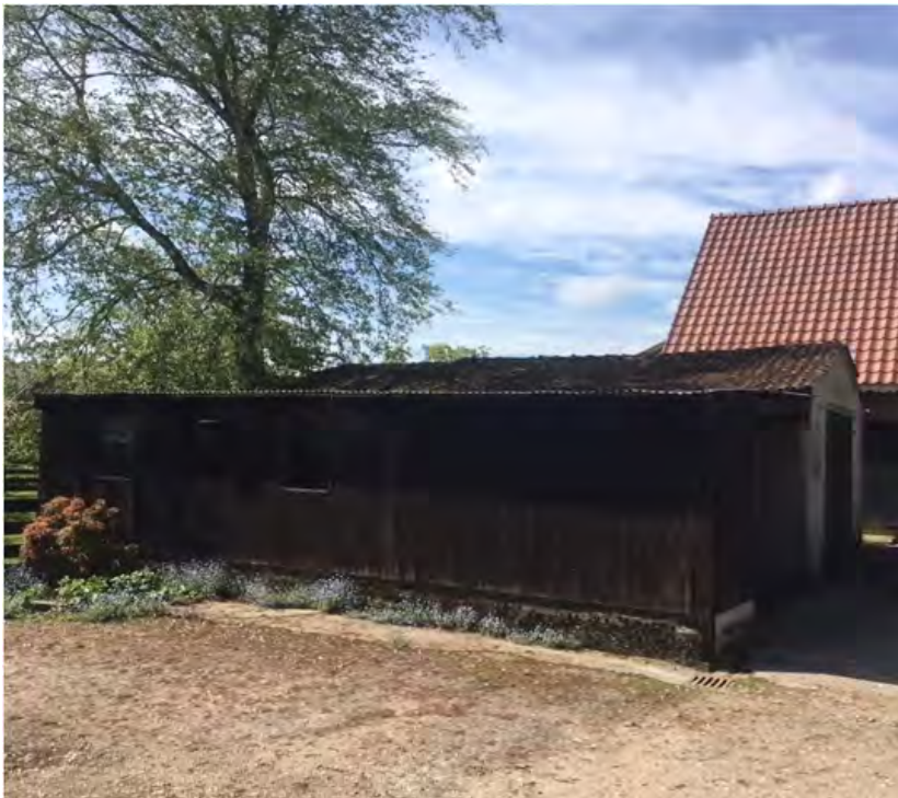
Figuur 5: opstal 3 in gebruik als stalling landbouwwerktuigen
