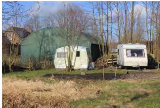
Eén van de te slopen romneyloodsen.
