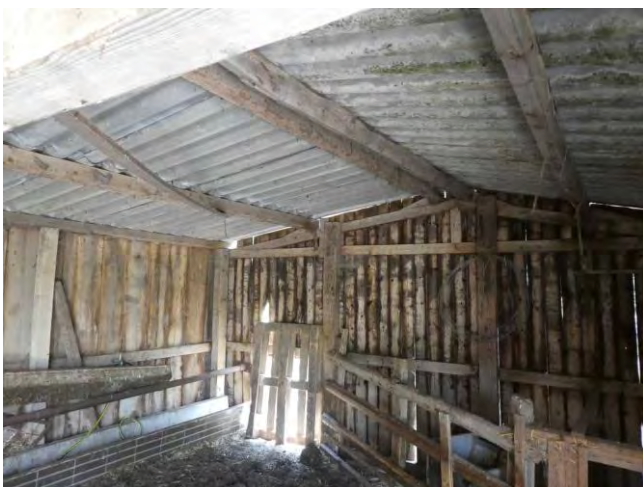
Figuur 13: Binnenkant schuur 3
