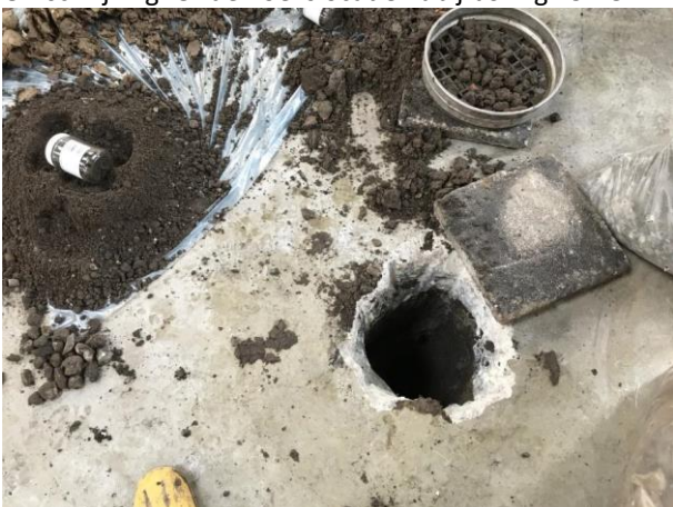
Fotonummer: 9 Omschrijving: Proefgat 03
