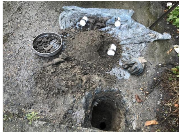
Fotonummer: 8 Omschrijving: Proefgat 01
