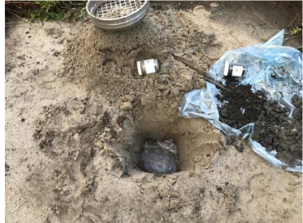
Fotonummer: 18 Omschrijving: Proefgat 12
