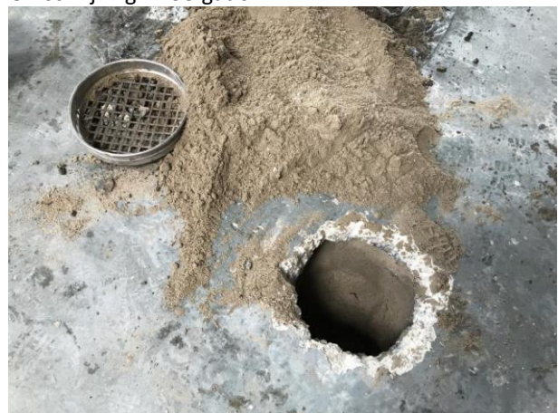
Fotonummer: 10 Omschrijving: Proefgat 04
