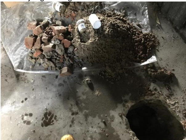
Fotonummer: 19 Omschrijving: Proefgat 13
