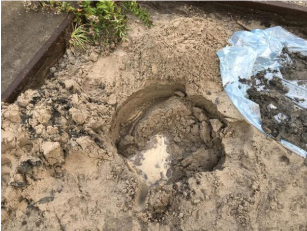
Fotonummer: 17 Omschrijving: Proefgat 11
