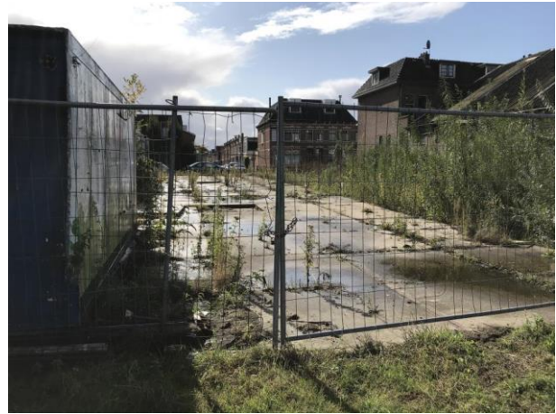
Fotonummer: 6 Omschrijving: Onderzoekslocatie ter plaatse van stelconverharding (boring 11 en 12)
