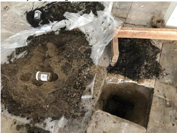
Fotonummer: 13 Omschrijving: Proefgat 07
