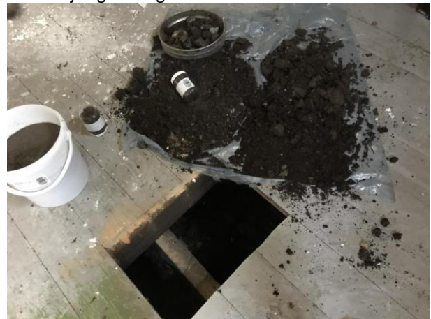
Fotonummer: 20 Omschrijving: Proefgat 14
