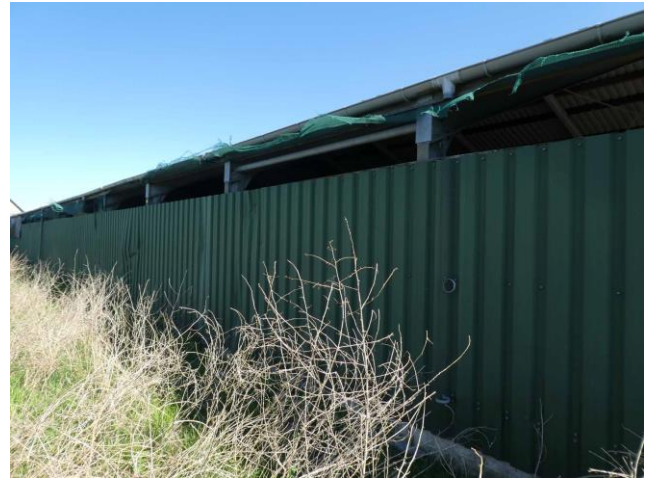
Figuur 17 Buitenzijde schuur 1
