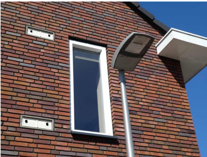
Figuur 25 Voorbeeld ingebouwde huismuskasten
