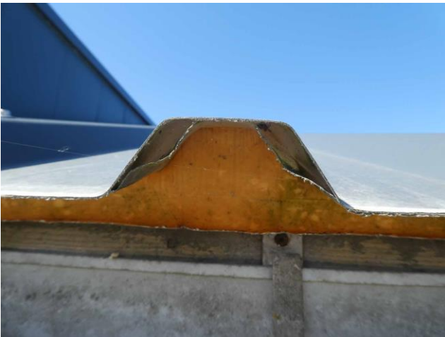
Figuur 16 Steenwol isolatie in dak schuur 1
