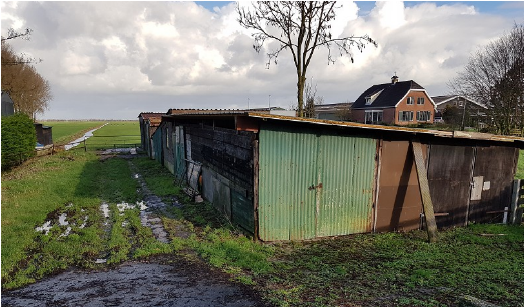
Zuidelijke en westelijke gevels van de opstallen, kijkrichting naar het noorden.
