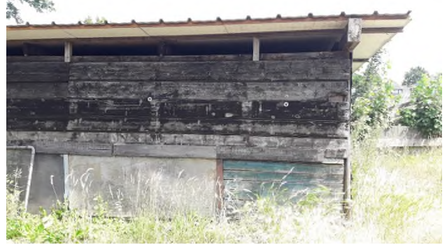
Fotonummer: 2: Opbouw schuur
