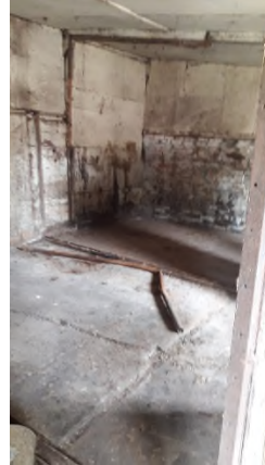
Fotonummer: 4: verharding schuur met beton
