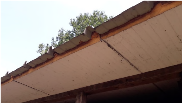
Fotonummer: 5: dak schuren, golfplaat dakje met isolatiemateriaal
