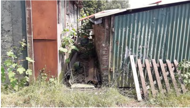
Fotonummer: 7: Bouwmaterialen tussen schuren
