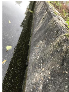
Foto 8: Beschoeiing oever Oude Rijn ter plaatse van de onderzoekslocatie
