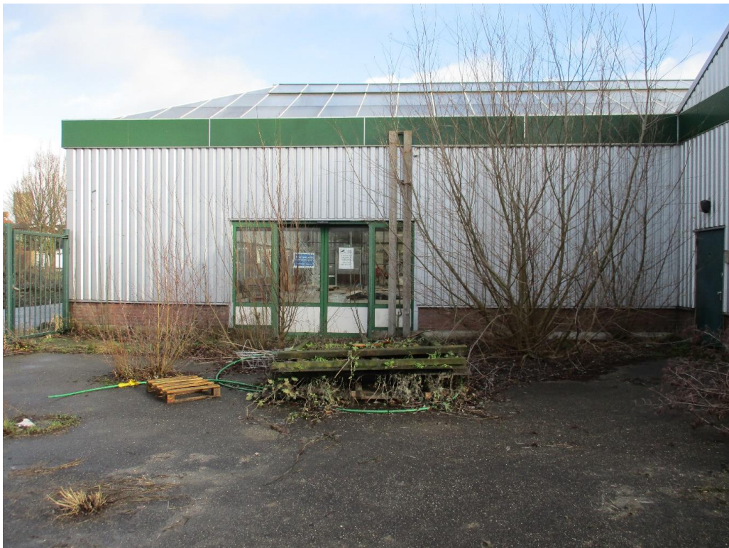
Figuur 2 De wand aan de zuidzijde is uit metalen golfplaat opgetrokken
