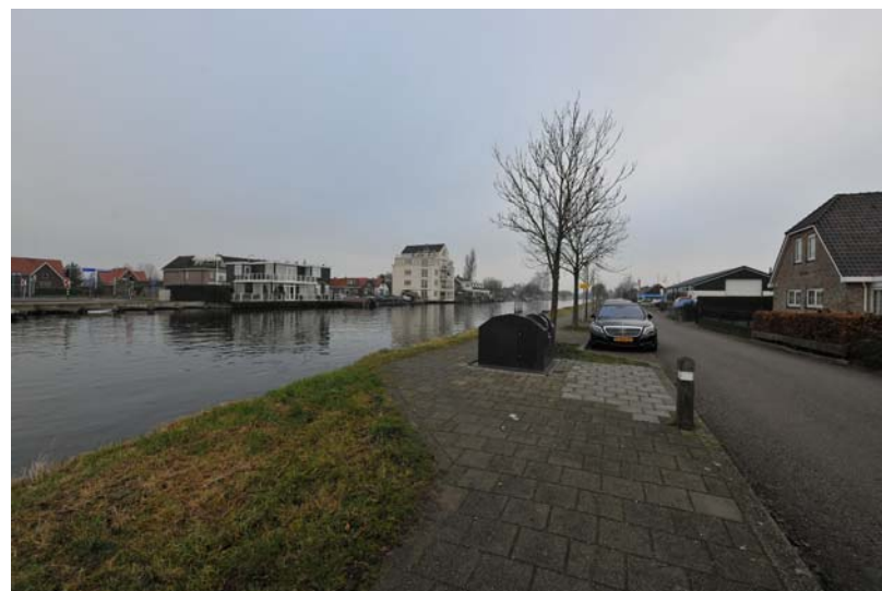
4. Ondergrondse containers langs Notaris d'Aumerielaan met op achtergrond bebouwing langs Zoutmansweg
