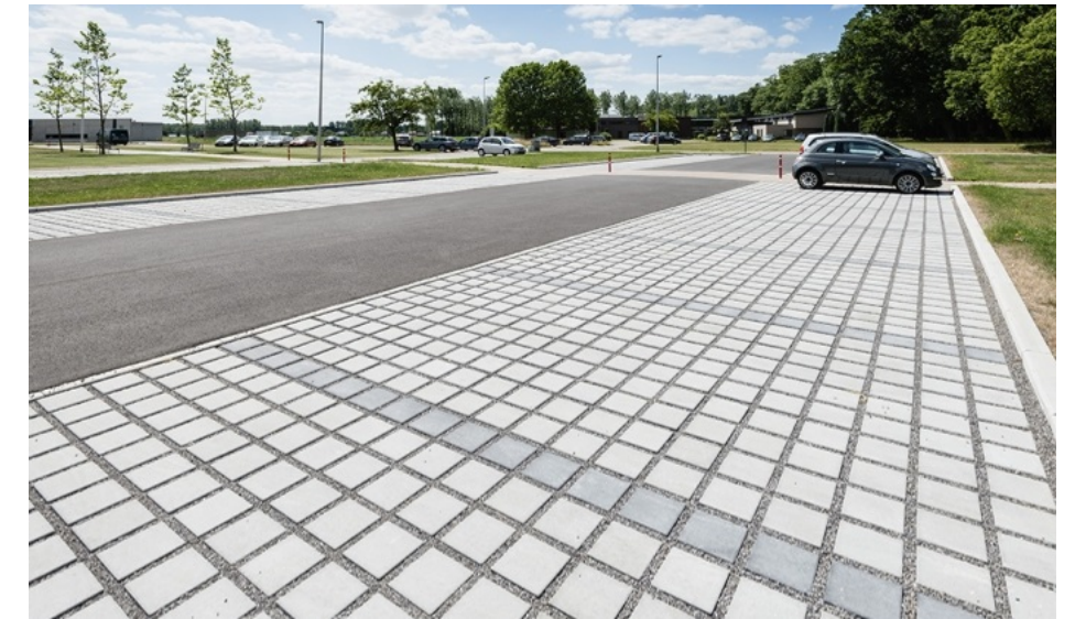
Grasbetontegels opgevuld met een granulaat
