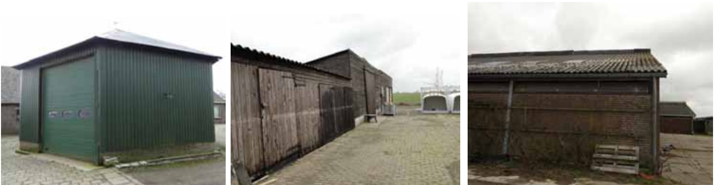
Figuur 9: golfplaten dakbedekking van de af te breken opstallen.
