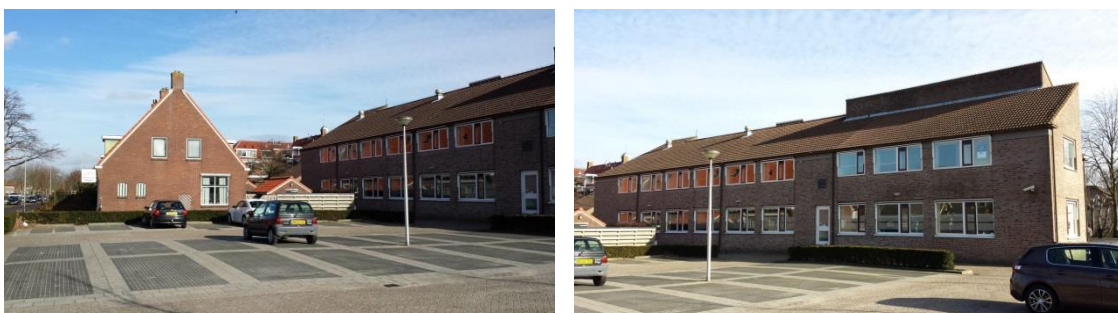
Figuur 3.2: Bestaand plangebied ten westen van het gebouw.
