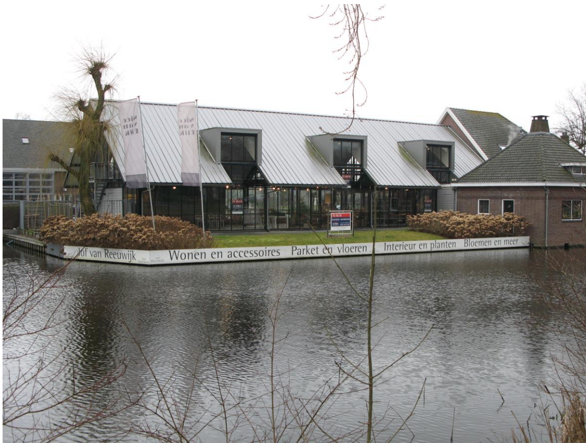
Bestaand pand vanaf Raadhuisweg, Reeuwijk- Brug.
