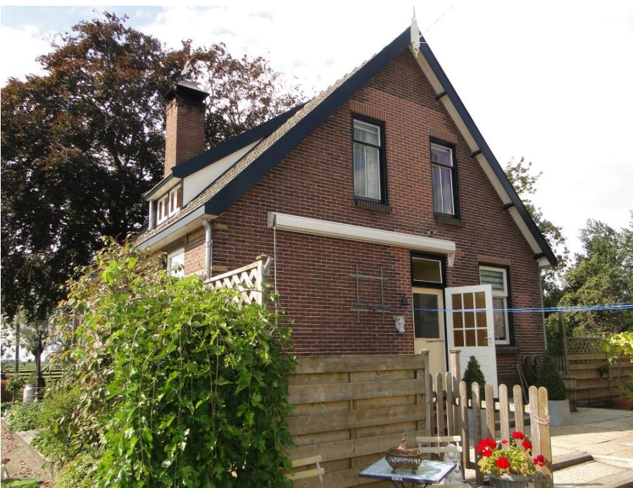
Figuur 28: achtergevel van het woonhuis, dat in zeer goede staat verkeert.
