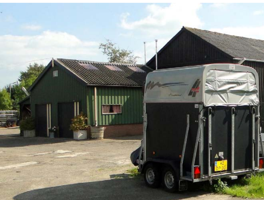
Figuur 20: de metalen loods aan de zuidwestzijde van het plangebied (nr. 14).
