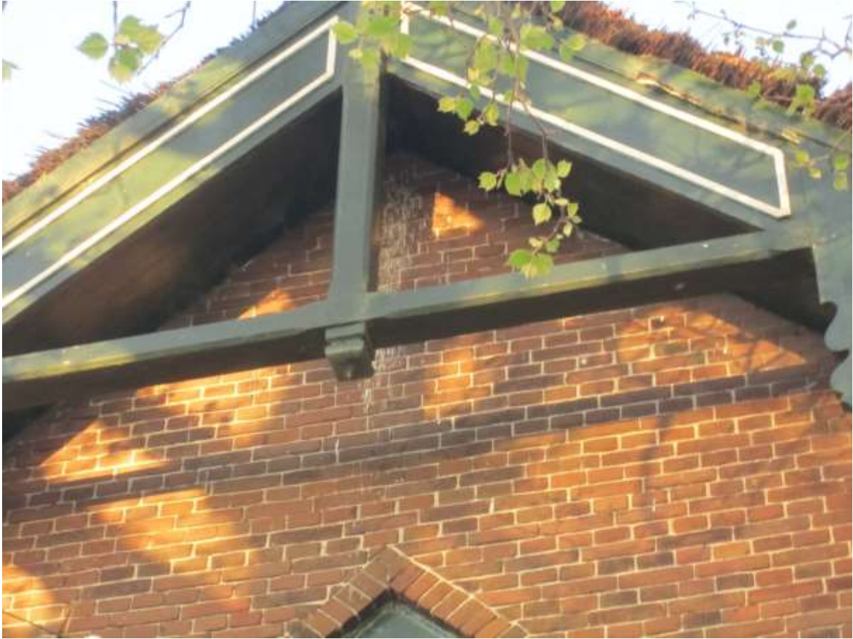
Foto 11. Poepsoren van vleermuizen in de nok van de gevel van de af te breken boerderij.
