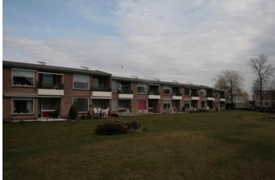
Foto 3, bebouwing zorgcentrum Kerveland, omringd door gazons
