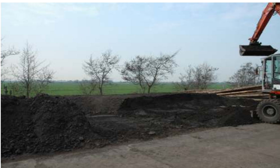
Opslag van grond.
