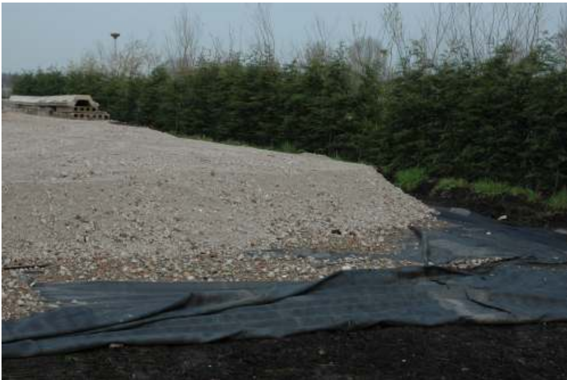
Doek met gebroken puin. Vanaf zuidzijde.
