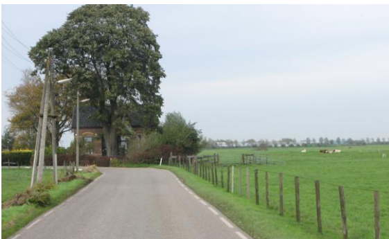
Hoek Tempeldijk/ Middelweg, waar de nieuwe aansluiting is gepland op de Rondweg Oost.
