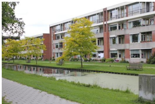
Te slopen woningen aan de Dronensingel.
