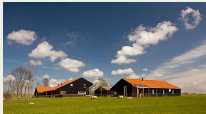
Nieuw ensemble nieuwe gebouwen (Faro Architecten)
