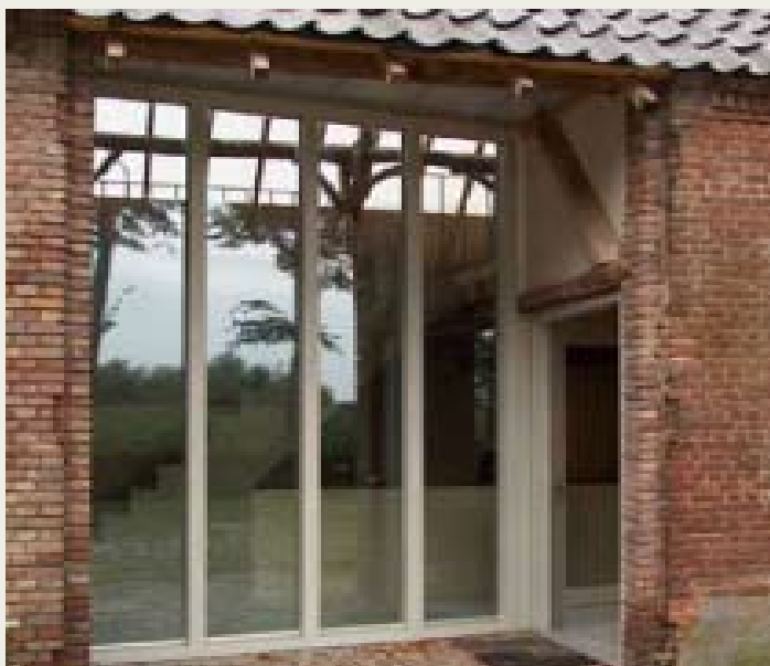
Voorbeeld nieuwe entree met lichte hal en trappenhuis (de voordeur zelf, staat open op de foto)
