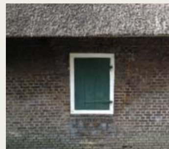
Referentiebeelden bestaande kwaliteit voor restauratie
