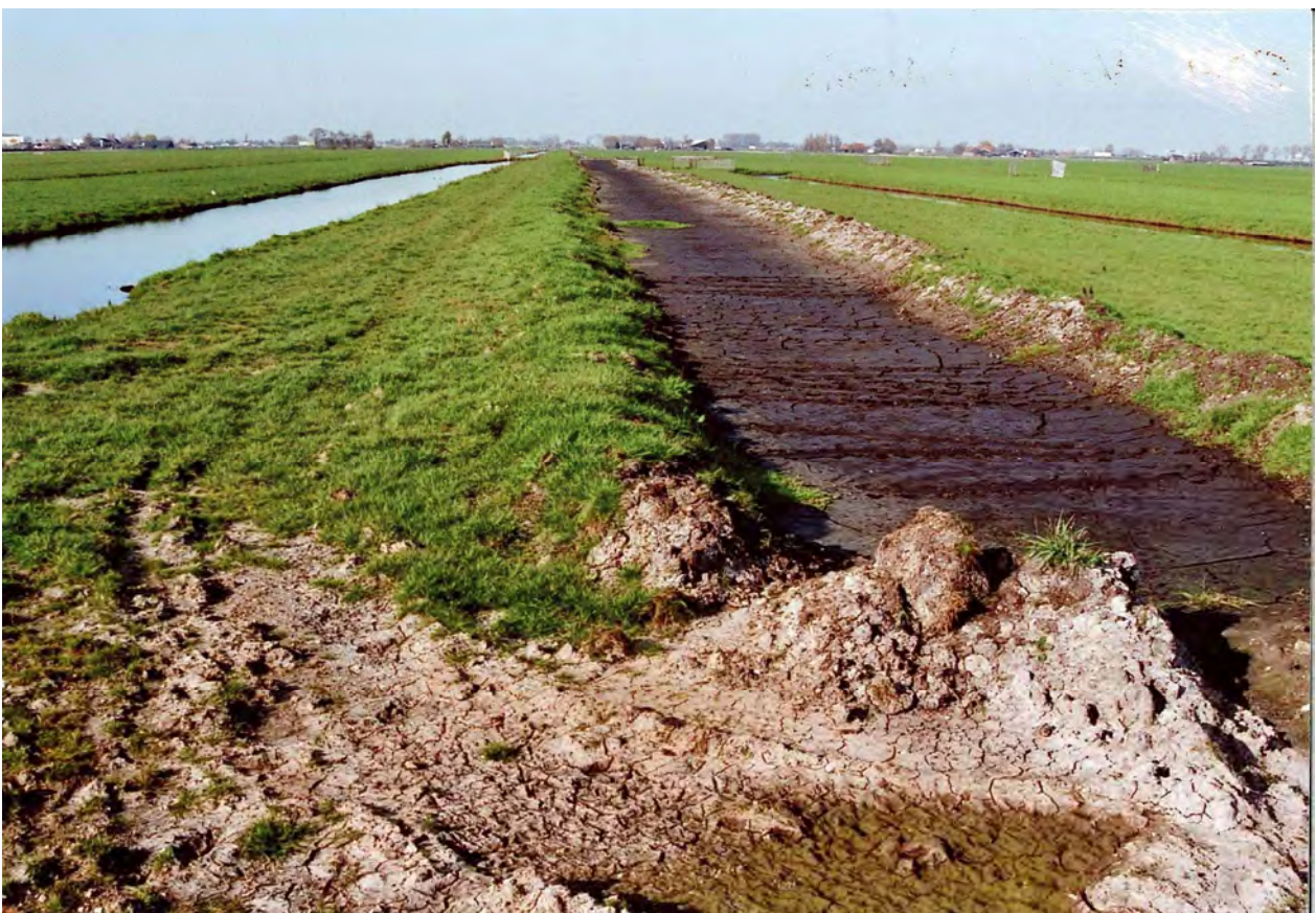
Figuur 52: Door het dempen wordt de heirweg onherkenbaar in het landschap
