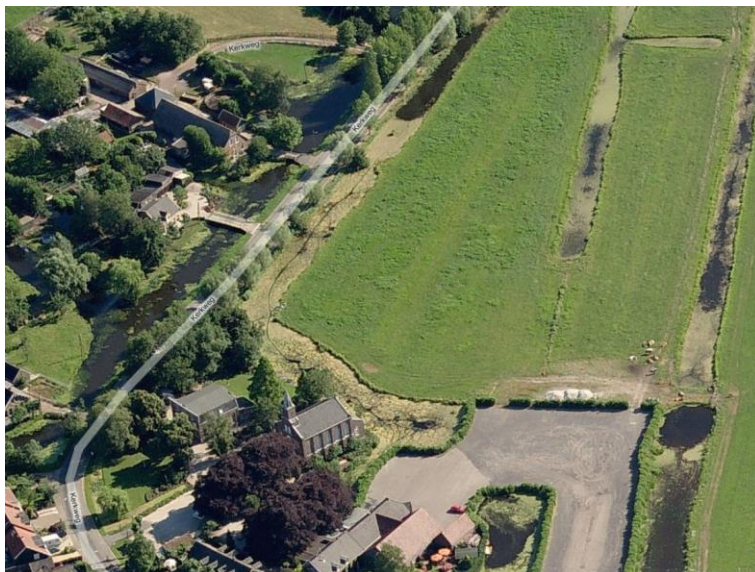
Luchtfoto bouwvlak plangebied (linksboven).
