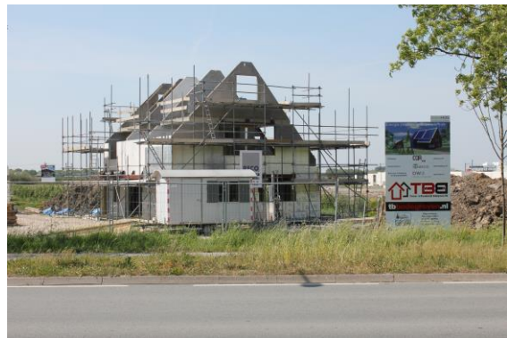
In aanbouw zijnde woning aan Dammekant 10.
