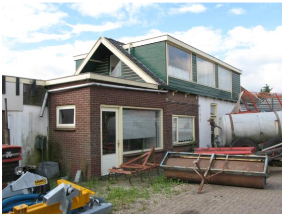
De te slopen twee woningen.
