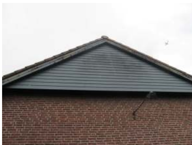
Figuur 7: De met hout afgewerkte kopse kanten van het gebouw
