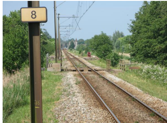
Spoorlijn achter het plangebied.
