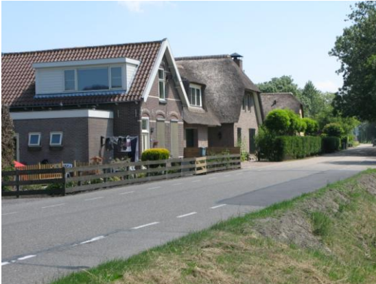
Woningen aan de Zuidzijde.
