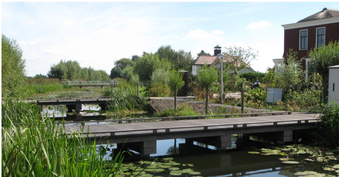
Voor de woning Oudeweg 94 zal eenzelfde brug worden gerealiseerd als bij de woningen Oudeweg 90 en 92 ter ontsluiting op de Kooidijk.
