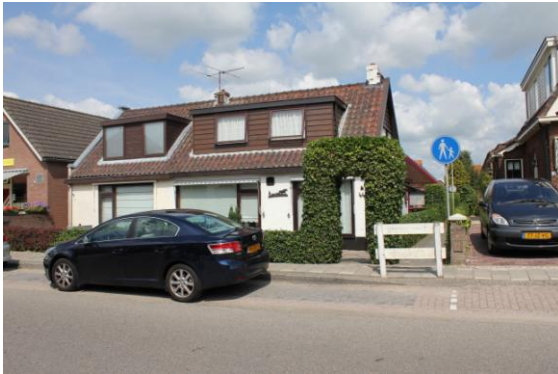
De voetgangersverbinding met links hiervan de twee te slopen woningen.
