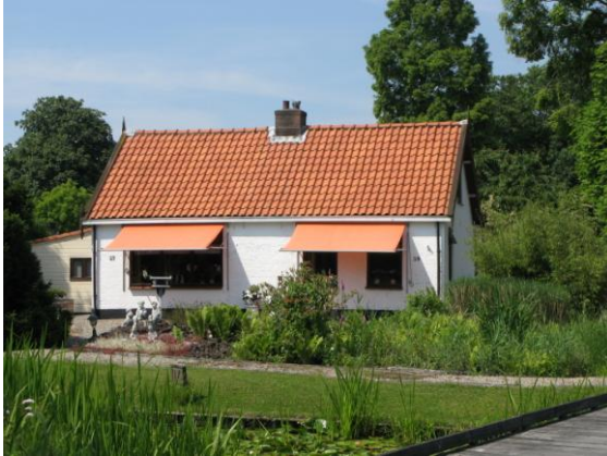
De bestaande twee-onder-één-kap woning.
