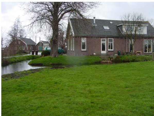
Afbeelding 5: de locatie Spoelwijkerlaan/Wijkdijk, gezien vanuit het zuiden.
