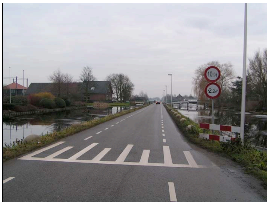
Het deel Middelburgseweg bij de veiling dat verbreed dient te worden. Verbreding kan alleen plaatsvinden als delen van het naastliggende water worden gedempt.
