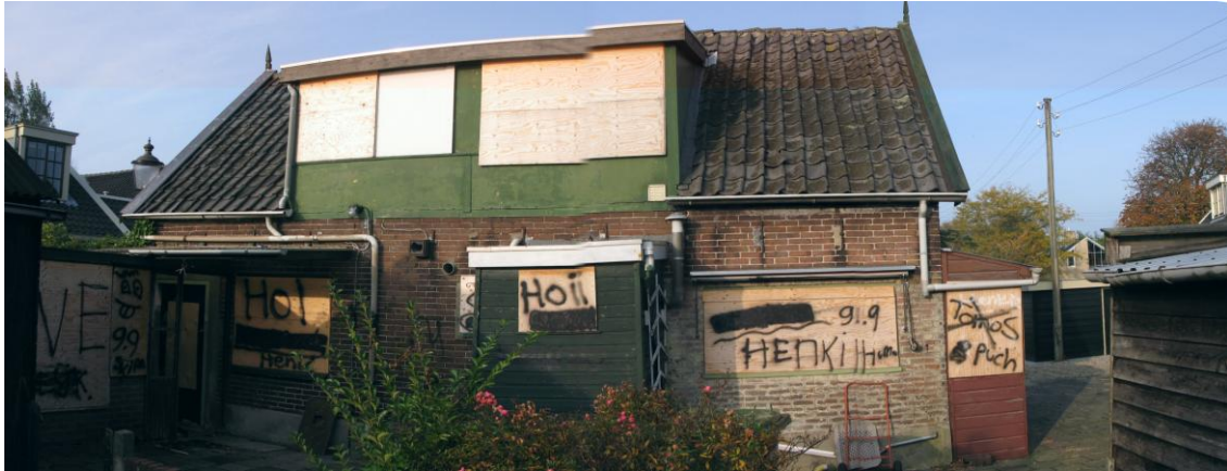
De achterzijde van de woningen 84 en 86. Een verrommeld beeld dat wordt hersteld door nieuwbouw.
